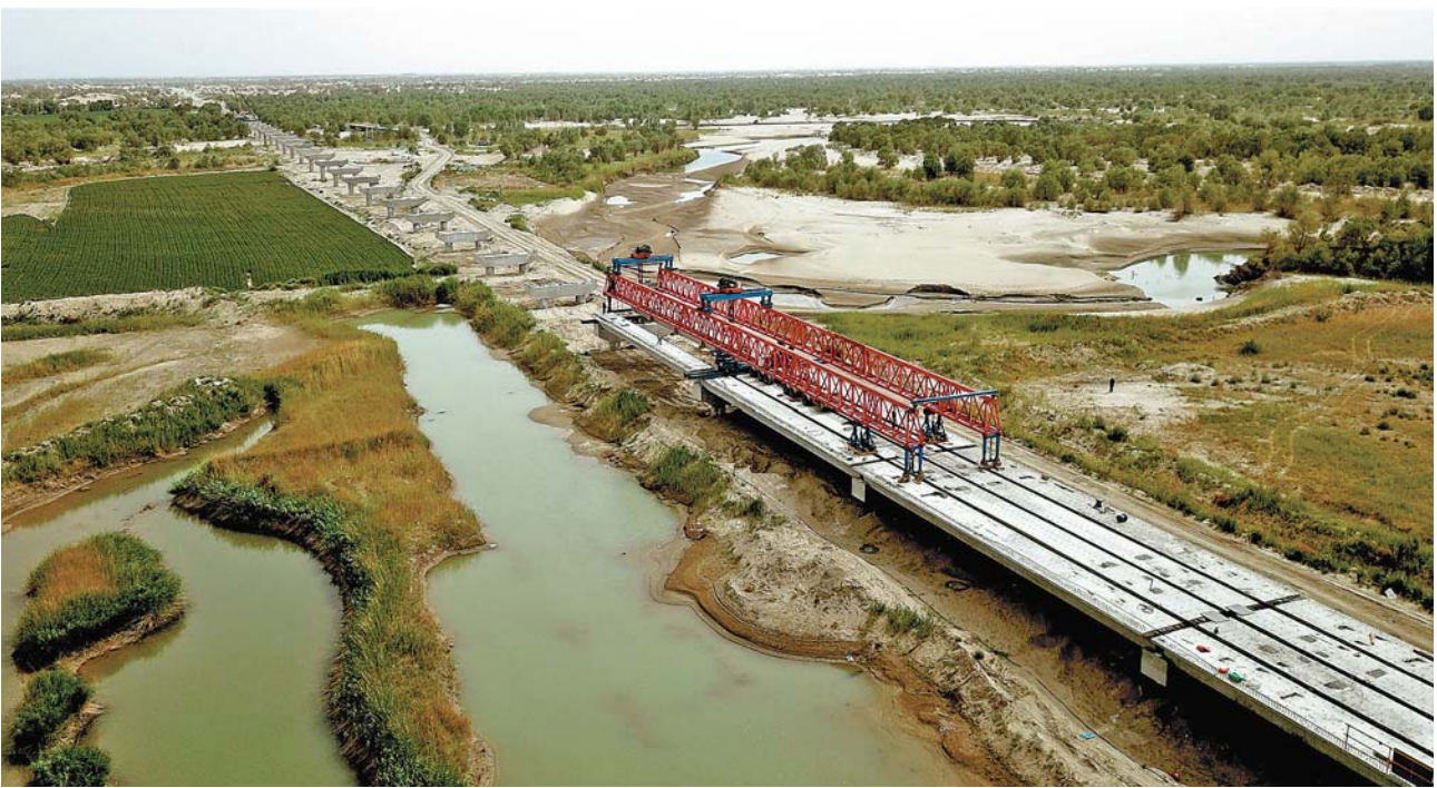
7 - ئاينىڭ 5 - كۈنى، قۇرۇلۇش خادىملىرى كۆۋرۈك قۇرۇشتۇرۇش مەشغۇلاتى ئېلىپ بارماقتا. شۇ كۈنى، لوپنۇر - چەرچەن قۇملۇق تاشيولىدىكى تارم دەرياسى ئالاھىدە چوڭ كۆۋرۈكى قۇرۇشتۇرۇلۇشقا باشلىدى. بۇ كۆۋرۈكنىڭ ئومۇمىي ئۇزۇنلۇقى 1290 مېتىر بولۇپ، مۆلچەرلىنىشىچە، 10 - ئاينىڭ ئاخىرى قۇرۇشتۇرۇلۇپ بولىدۇ. كەن. لوپنۇر - چەرچەن قۇملۇق تاشيولىنىڭ ئومۇمىي ئۇزۇنلۇقى 333 كىلومېتىر كېلىدۇ، بۇنىڭ ئىچىدە قۇملۇق يول بۆلىكى 304 كىلومېتىر بولۇپ، شىنجاڭدىكى 3 - قۇملۇق تاشيولى ھېسابلىنىدۇ. □ چىن جىيەننى فوتوسى
